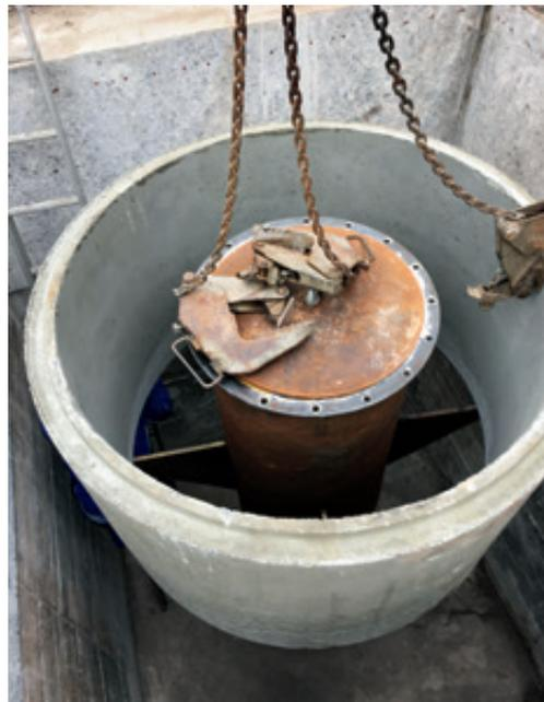
Abb. 12: Verlängerung eines Brunnenkopfrohrs nach oben
